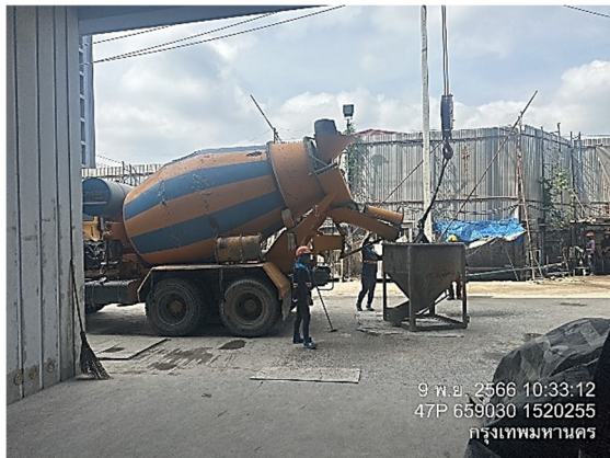
ภาพที่ 19 รถบรรทุกปูนซีเมนต์แบบสำเร็จรูปพร้อมใช้งาน
