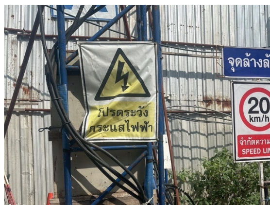
ภาพที่ 43 ติดตั้งป้ายเตือนอันตรายบริเวณตู้ไฟฟ้าชั่วคราว
