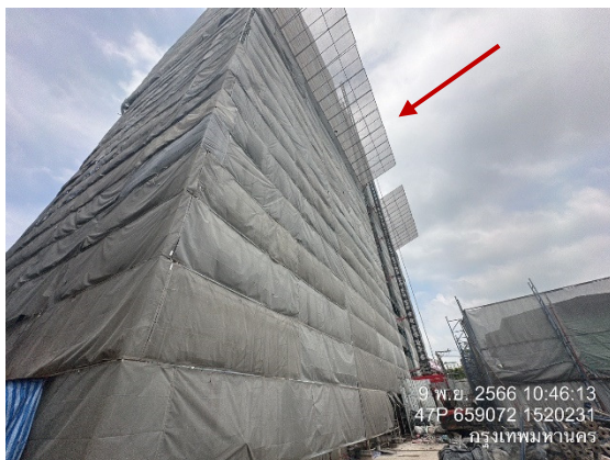
ภาพที่ 80 Chain Link ยื่นจากอาคาร
