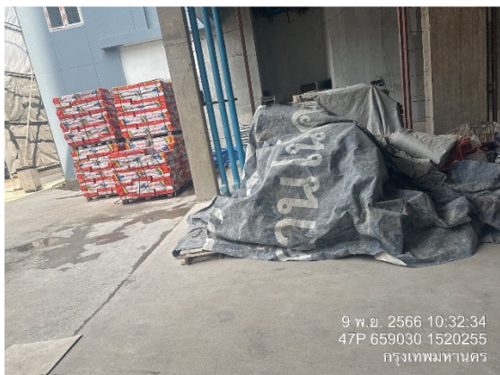
ภาพที่ 13 ปิดคลุมวัสดุก่อสร้างที่มีฝุ่นอย่างมิดชิด
