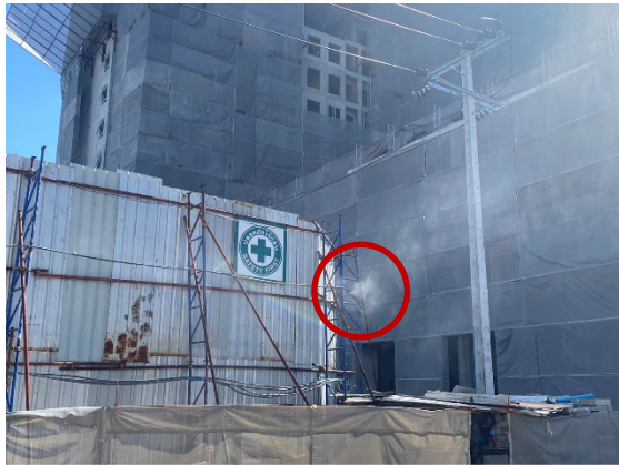
ภาพที่ 9 ติดตั้งสเปรย์น้ำ
