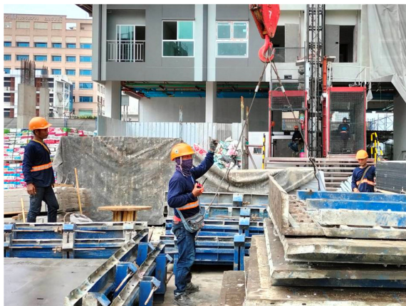
ภาพที่ 22 การลำเลียงวัสดุก่อสร้างขนาดใหญ่โดยใช้เครนยก
