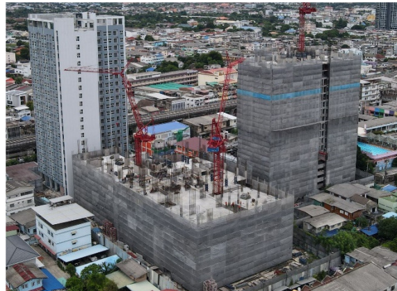
ภาพที่ 12 การติดตั้ง Mesh Sheet คลุมตัวอาคาร
