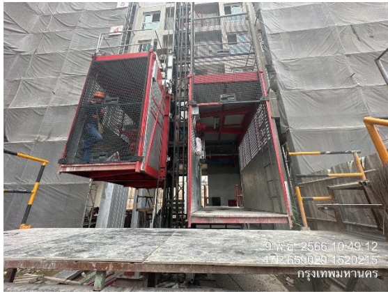
ภาพที่ 82 ลิฟต์ขนถ่ายวัสดุก่อสร้าง
